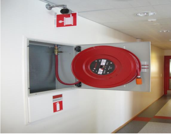
Bild 2 (Snabbrandpost- och släckarskåp)
