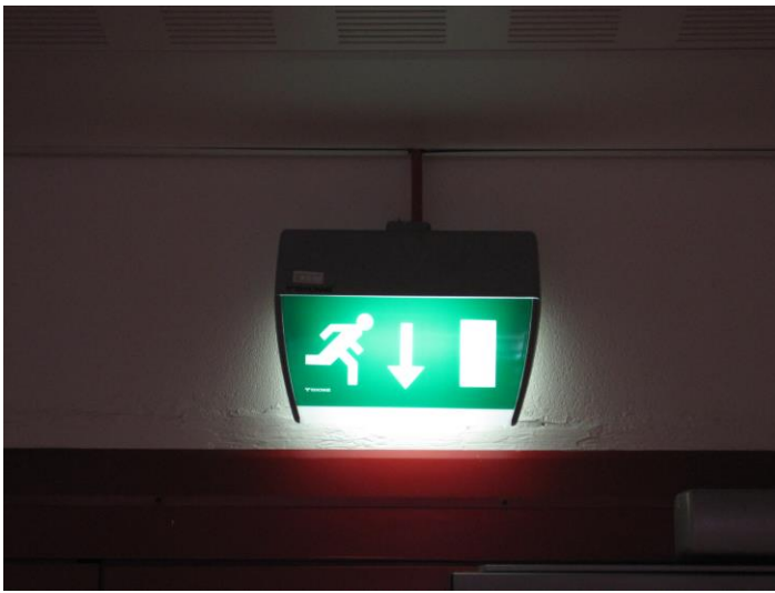
Bild 1 (signalbelysning som visar utrymningsriktningen)
